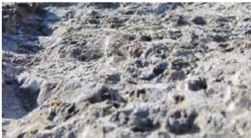
Ilustración 20. Superficie rugosa usando martillo rompedor de concreto portátil antes de una preparación adicional. Fuente: ICRI 310.2R, 2013.
