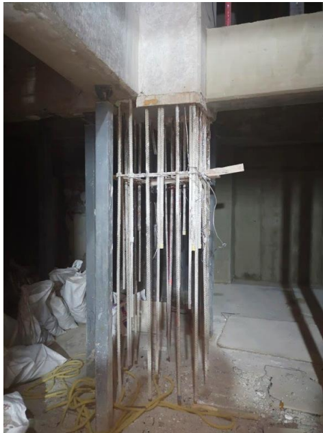
Ilustración 14. Columna demolida y reemplazada por un nuevo elemento. Fuente: Rubén Bautista, 2019.
