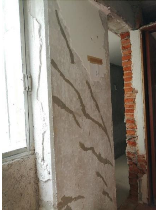
Ilustración 12. Columna de concreto después de la inyección. Fuente: Jorge Abarca, 2019.
