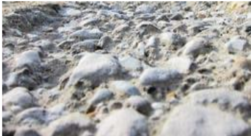
Ilustración 21. Superficie rugosa seguida de chorro abrasivo para quitar el sustrato fracturado. Fuente: ICRI 310.2R, 2013.
