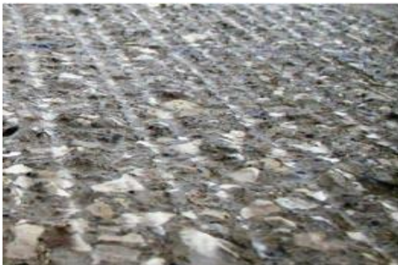
Ilustración 18. Superficie de concreto preparado con rotofresado. Fuente: ICRI 310.2R, 2013.
