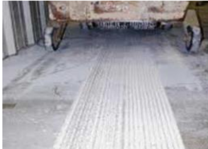
Ilustración 17. Superficie escarificada con máquina que muestra marcas de dientes. Fuente: ICRI 310.2R, 2013.
