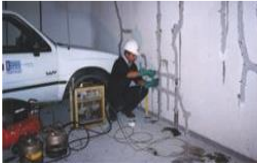
Ilustración 10. Inyección de resinas con bombas eléctricas.
