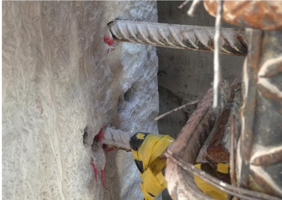
Ilustración 23. Barras corrugadas de acero colocadas dentro de un agujero con resina epóxica. Fuente: Rubén Bautista, 2019.
