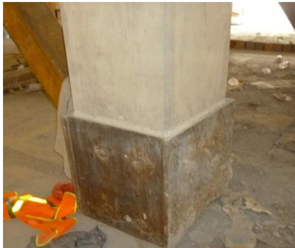
Ilustración 24. Encamisado local, sujetado con conectores y mortero fluido entre el concreto y el acero. Fuente: Archivo personal de Víctor Cruz, 2019.
