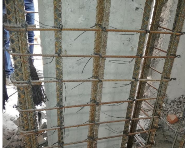
Ilustración 13. Práctica incorrecta: estribos con dobleces a 90 grados. Fuente: Archivo personal de Víctor Cruz, 2019
