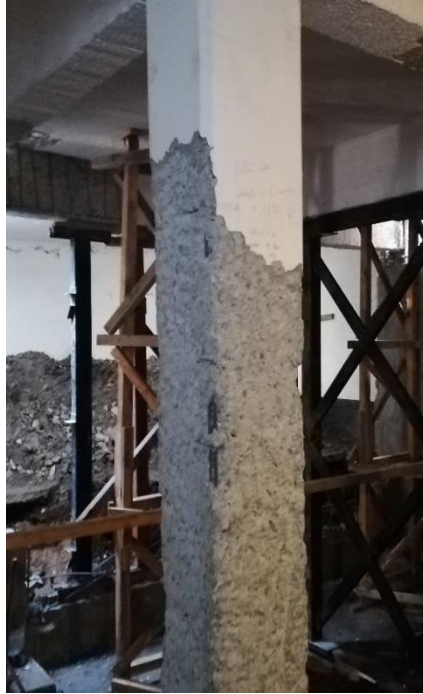
Ilustración 17. Ejemplo de preparación de la superficie de una columna existente. Fuente: Archivo personal de Víctor Cruz, 2019.
