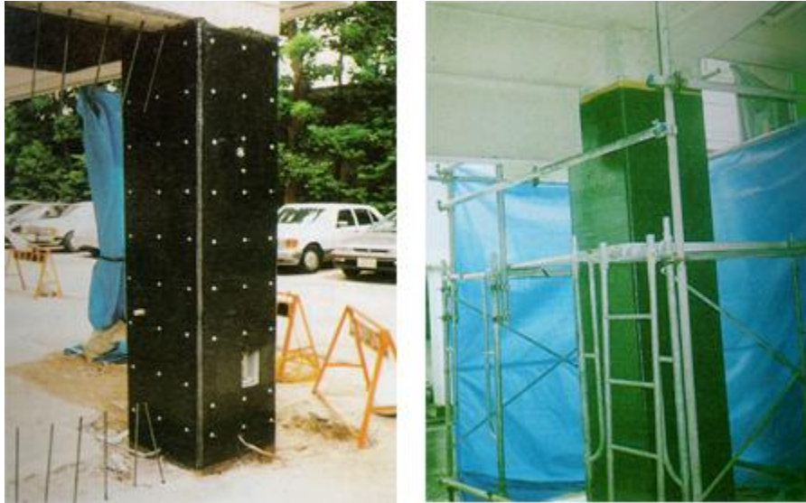
Ilustración 39. Aplicación de un encamisado completo en columnas, con y sin conectores. Fuente: Cortesía de Oscar López, 1995.
