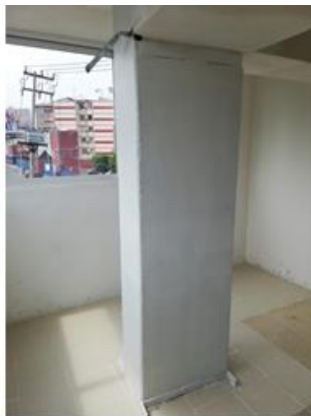
a) Columna con encamisado completo sin conectores
