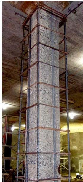
Ilustración 4. Columna encamisada con refuerzo longitudinal discontinuo en la altura del edificio. Nótese que la cuantía de estribos no es muy alta. Fuente: https://esemag.com/
