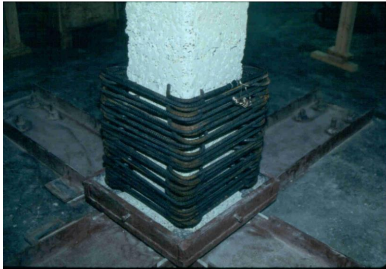
Ilustración 8. Ejemplo del uso de estribos en forma de letra L en encamisados de columnas. Fuente: Archivo personal de Sergio Alcocer, 1991
