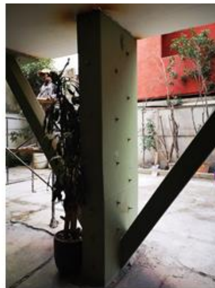
b) Columna con encamisado completo con conectores
