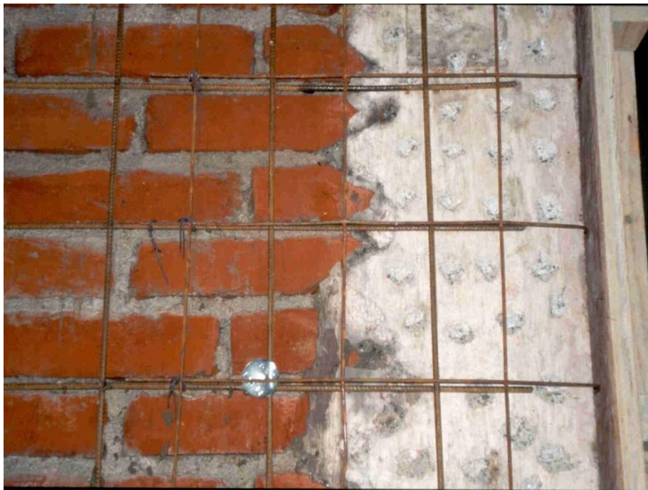
Ilustración 50. Práctica correcta: continuidad del refuerzo del encamisado en abertura, mediante traslape de malla en forma de letra C. Fuente: Archivo personal de Sergio Alcocer, 1996.
