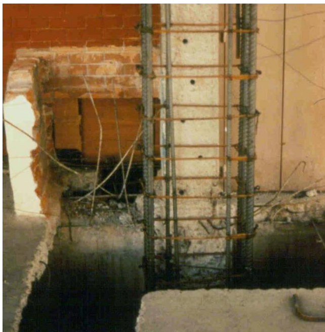
Ilustración 15. Columna con agujeros para instalar anclas ahogadas en resina epóxica. Fuente: Archivo personal de Sergio Alcocer, 1991.
