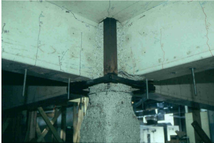
Ilustración 9. Armadura metálica hecha a base de ángulos verticales en las esquinas del nudo y de soleras horizontales arriba de la losa y por debajo de las vigas. Fuente: Archivo personal de Sergio Alcocer, 1991
