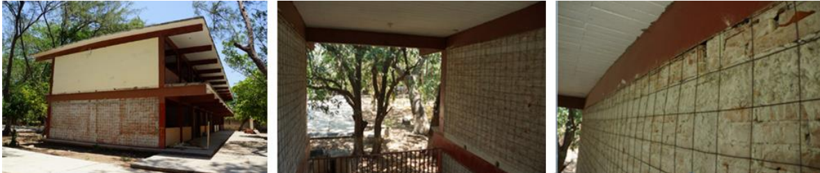
Ilustración 47. Uso de encamisado de muros de mampostería para rehabilitar una escuela.
