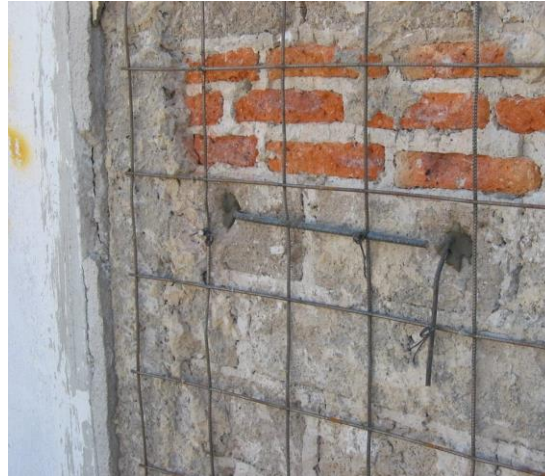
Ilustración 64. Sujeción de malla de alambre soldado mediante grapas (en forma de letra C). Fuente: Archivo personal de Sergio Alcocer, 2003.
