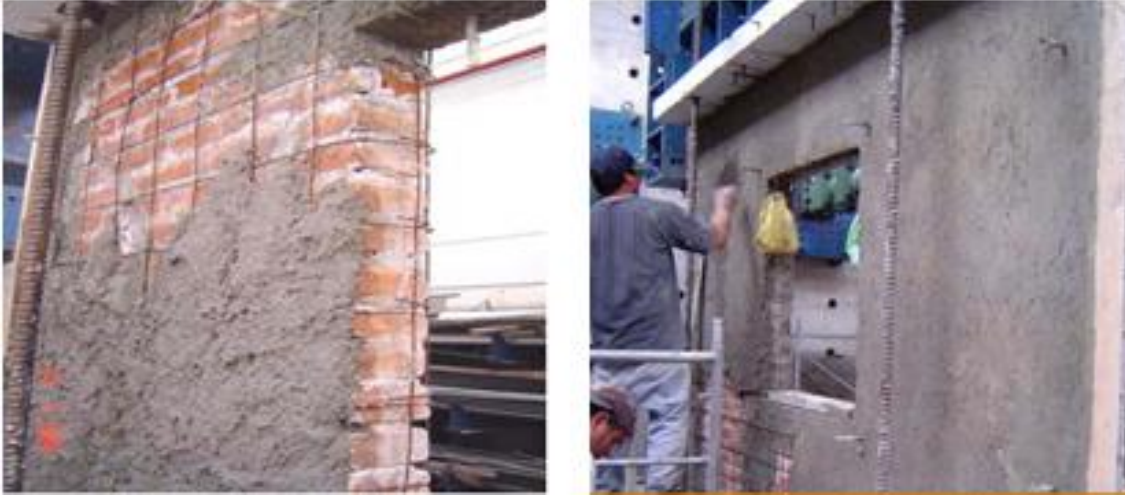
Ilustración 65. Colocación por medios manuales del mortero sobre la malla de alambre soldado. Fuente: Flores et al., 2004.
