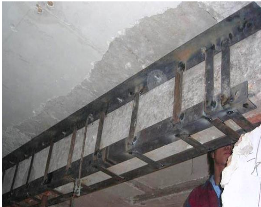
Ilustración 20. Encamisado de vigas con ángulos y soleras. Fuente: Horse Construction Company China www.horseen.com
