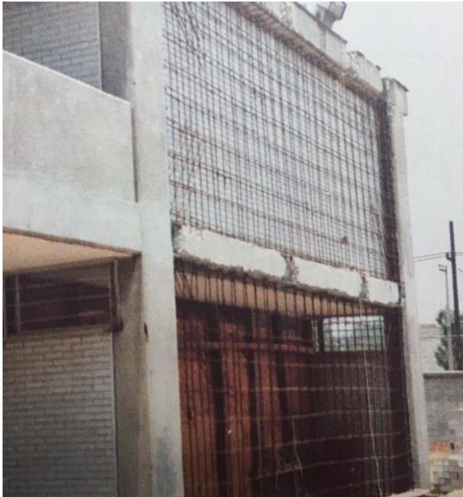
Figura 2. Rigidización de una estructura mediante nuevos muros.
