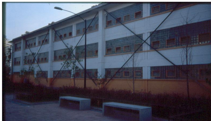
Figura 5. Ejemplo de un contraventeo con cables postensados. Fuente: Cortesía de Grupo Riobóo, 2020
