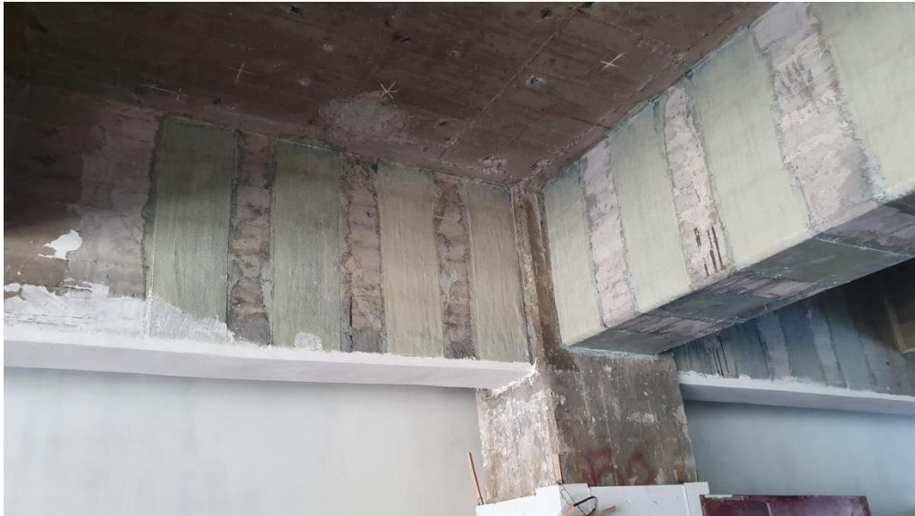
Figura 6. Ejemplos del uso de CFRP en vigas y columnas. Fuente: Archivo personal de Rubén Bautista, 2020.
