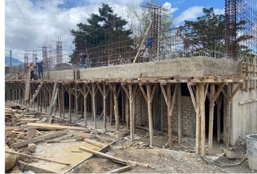
COLADO Y DESCIMBRANDO DE LOSA DE EDIFICIO U-2C (H)
