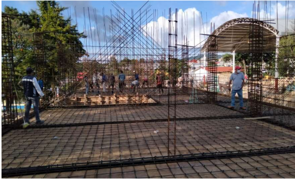
ARMADO Y CIMBRADO DE LOSA DE EDIFICIO U-2C (H)
