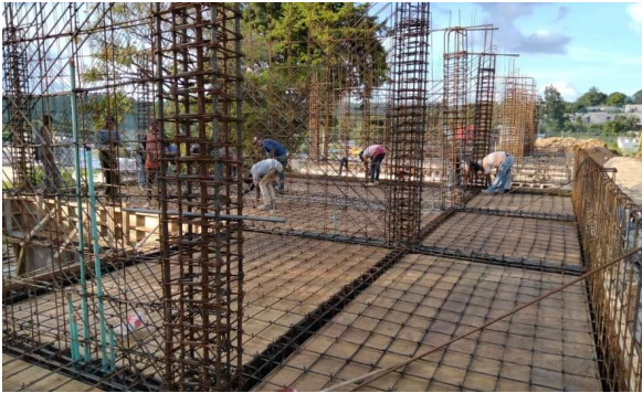
ARMADO Y CIMBRADO DE LOSA DE EDIFICIO U-2C (I)
