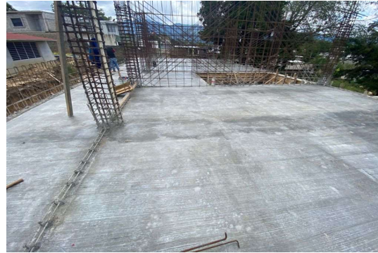
COLADO Y DESCIMBRANDO DE LOSA DE EDIFICIO U-2C (H)
