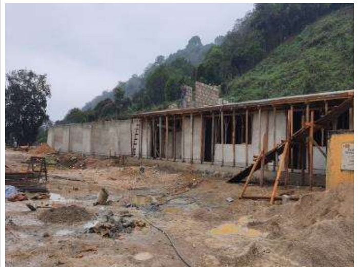
CONSTRUCCION DE 03 AULAS Y SERVICIOS SANITARIOS
