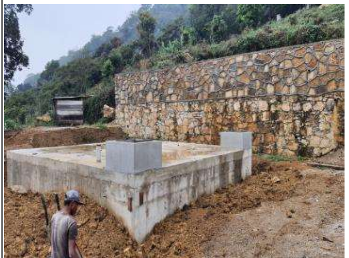
CONSTRUCCION DE CISTERNA
