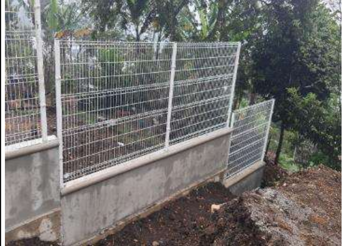
BARDA PERIMETRAL CON REJACERO
