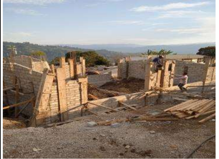
CONSTRUCCION DE BIBLIOTECA Y AULA DE MEDIOS
