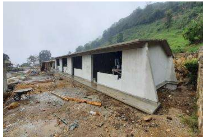
APLANADO CONSTRUCCION DE 04 AULAS DIDACTICAS RC
