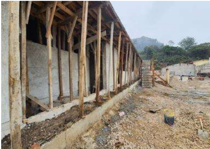
CONSTRUCCION DE 03 AULAS Y SERVICIOS SANITARIOS
