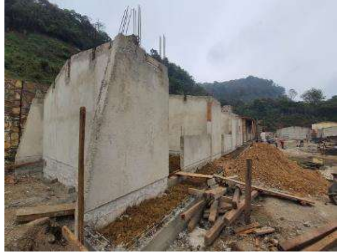
CONSTRUCCION DE 03 AULAS DIDACTICAS RC
