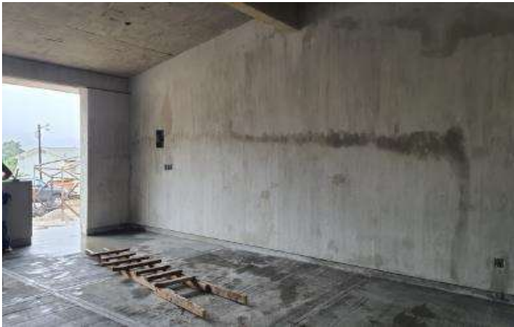
COLADO DE PISO EN CONSTRUCCION DE 04 AULAS DIDACTICA RC
