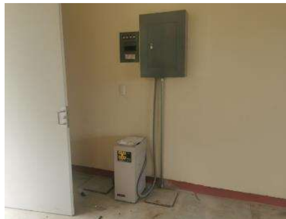
COLOCACION DE REGULADOR DE BOLTAJE EN AULA DE MEDIOS
