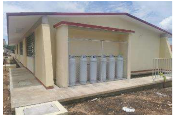
COLOCACION DE CILINDROS DE GAN EN AREA DE COCINA
