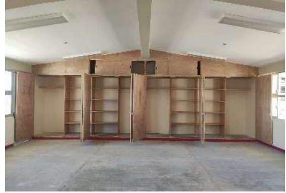
MUEBLE DE MADERA EN AULA DE USOS MÚLTIPLES
