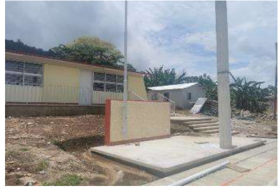
EDIFICIO C Y MURO DE ASTA BANDERA TERMINADO
