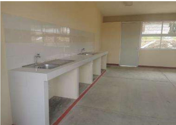
COLOCACION DE TARJAS EN AREA DE COCINA
