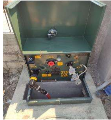
COLOCACION DE TRANSFORMADOR ELECTRICO
