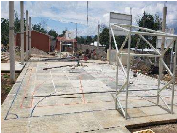
CANCHA DE USOS MÚLTIPLES TERMINADO
