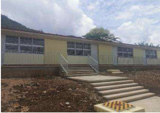
EDIFICIO E Y D TERMINADOS, ANDADORES
