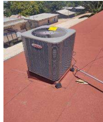
COLOCACION DE VENTILADOR DEL CLIMA EN LOSA DEL AULA DE MEDIOS
