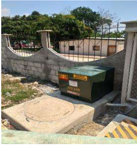
COLOCACION DE TRANSFORMADOR ELECTRICO
