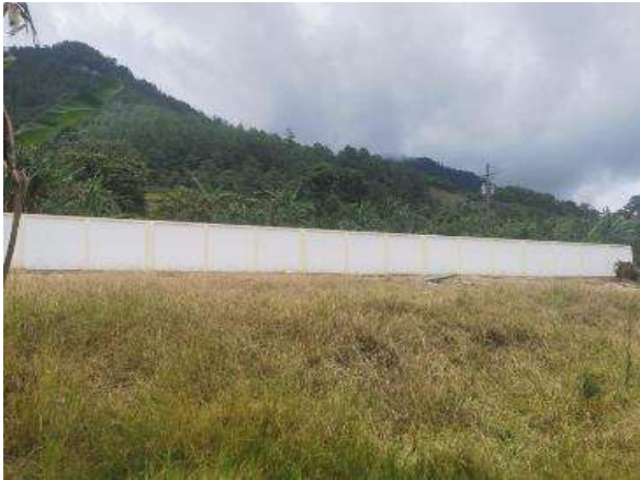
CONSTRUCCION DE BRADA PERIMETRAL
