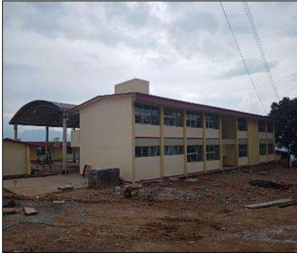
EDIFICIO U2-C (AL LADO LA CISTERNA)
