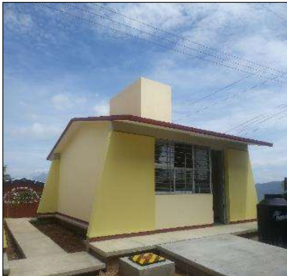
EDIFICIO DE AULA-COCINA
