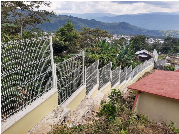
BARDA DE REJACERO
