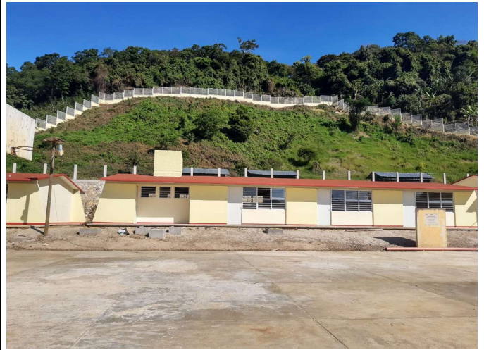
03 AULAS DIDACTICAS RC Y SERVICIO SANITARIO
