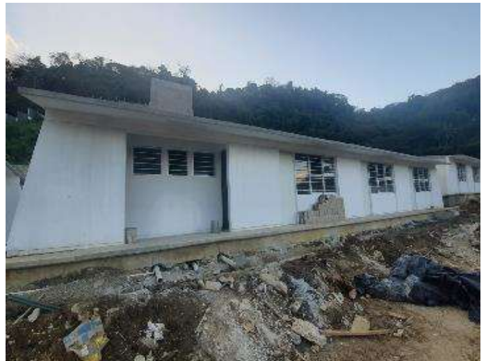
CONSTRUCCION DE 03 AULAS Y SERVICIOS SANITARIOS
