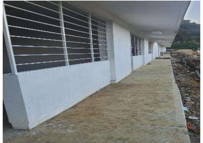
EDIFICIO "D" 4 AULAS DIDACTICAS RC
