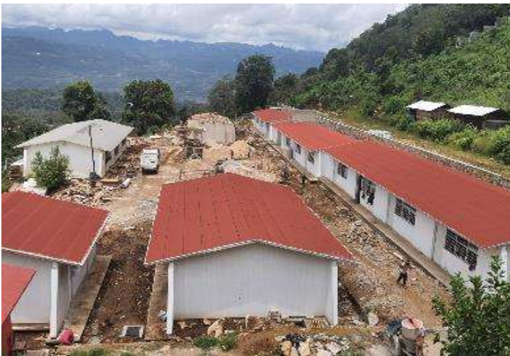
IMPERMEABILIZANTE EN EL EDIFICIO "A, B, C, D Y F"
