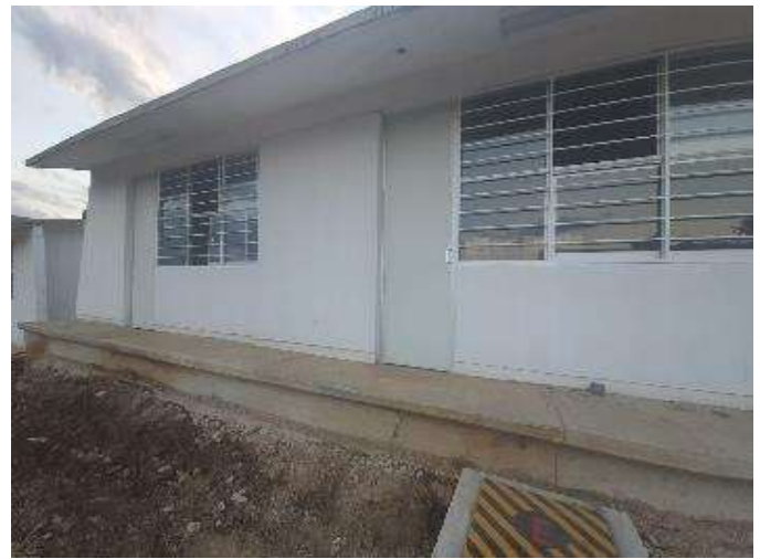
CONSTRUCCION DE BIBLIOTECA Y AULA DE MEDIOS
