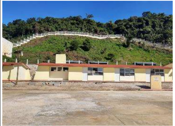
03 AULAS DIDACTICAS RC Y SERVICIO SANITARIO
