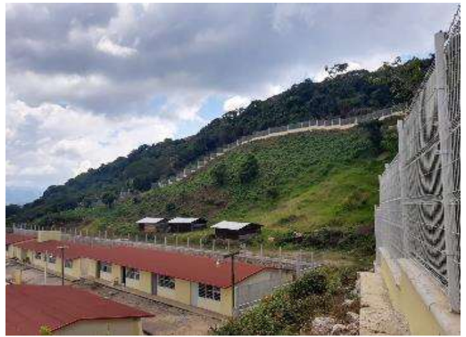
BARDA DE REJACERO
