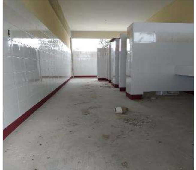
SERVICIO SANITARIO DE EDIFICIO U2-C TERMINADO
