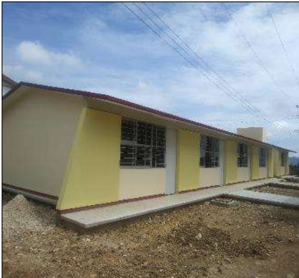
EDIFICIO DE 04 AULAS ESTRUCTURA RC
