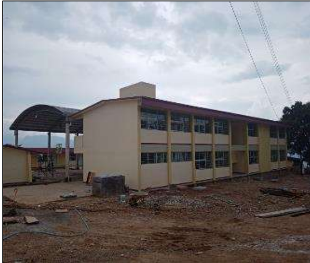
EDIFICIO U2-C (AL LADO LA CISTERNA)
