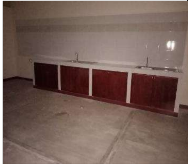
MUEBLE HECHO EN OBRA EN AULA-COCINA
