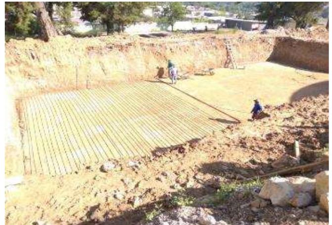
COLOCACION DE MATERIAL PEDRAPLEN, MATERIAL MEJORADO Y TENDIDO DE ACERO PARA EDIFICIO I U2-C
