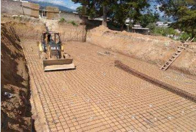
COLOCACION DE MATERIAL PEDRAPLEN, MATERIAL MEJORADO Y TENDIDO DE ACERO PARA EDIFICIO H U2-C
