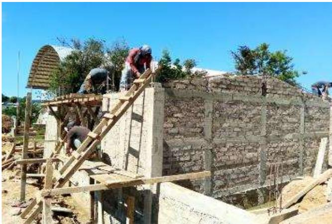
CIMBRADO Y ARMADO DE TRABES T-1 Y T-2, Y LOSAS EN EDIFICIO D
