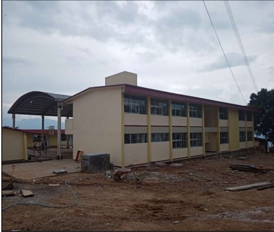
EDIFICIO U2-C (AL LADO LA CISTERNA)
