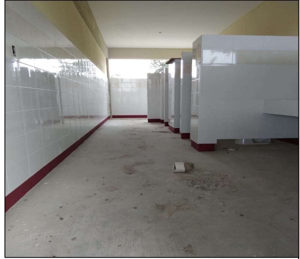
SERVICIO SANITARIO DE EDIFICIO U2-C TERMINADO
