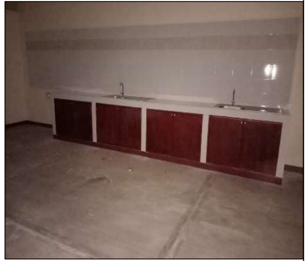
MUEBLE HECHO EN OBRA EN AULA-COCINA
