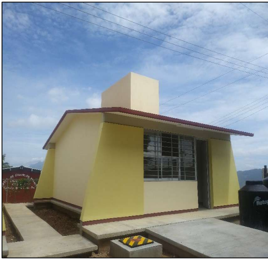
EDIFICIO DE AULA-COCINA
