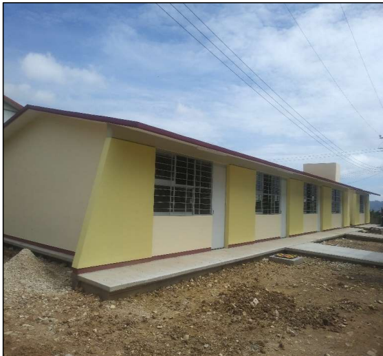
EDIFICIO DE 04 AULAS ESTRUCTURA RC
