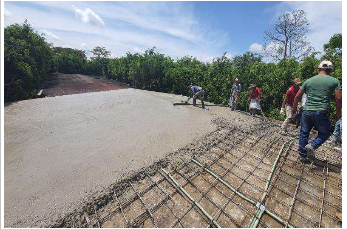
COLADO DE LOSA DEL EDIFICIO "E", 3 AULAS U-1C
