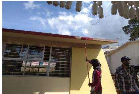
COLOCACION DE IMPERMEABILIZANTE EN LOSA DE EDIFICIO F
