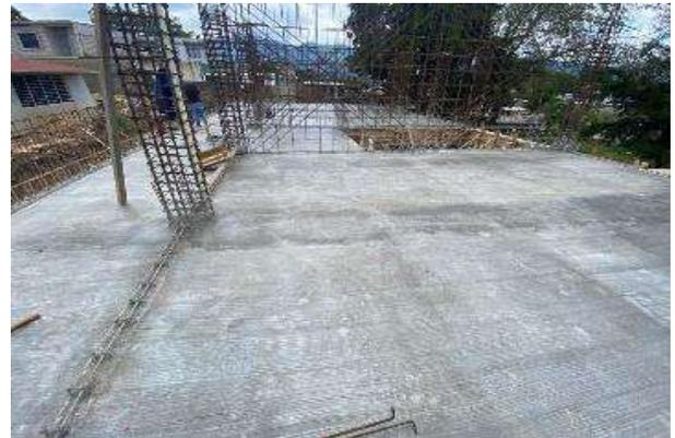
COLADO Y DESCIMBRANDO DE LOSA DE EDIFICIO U-2C (I)
